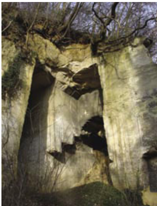
Photo 116 - Fenêtres d'accès vers les réseaux souterrains
