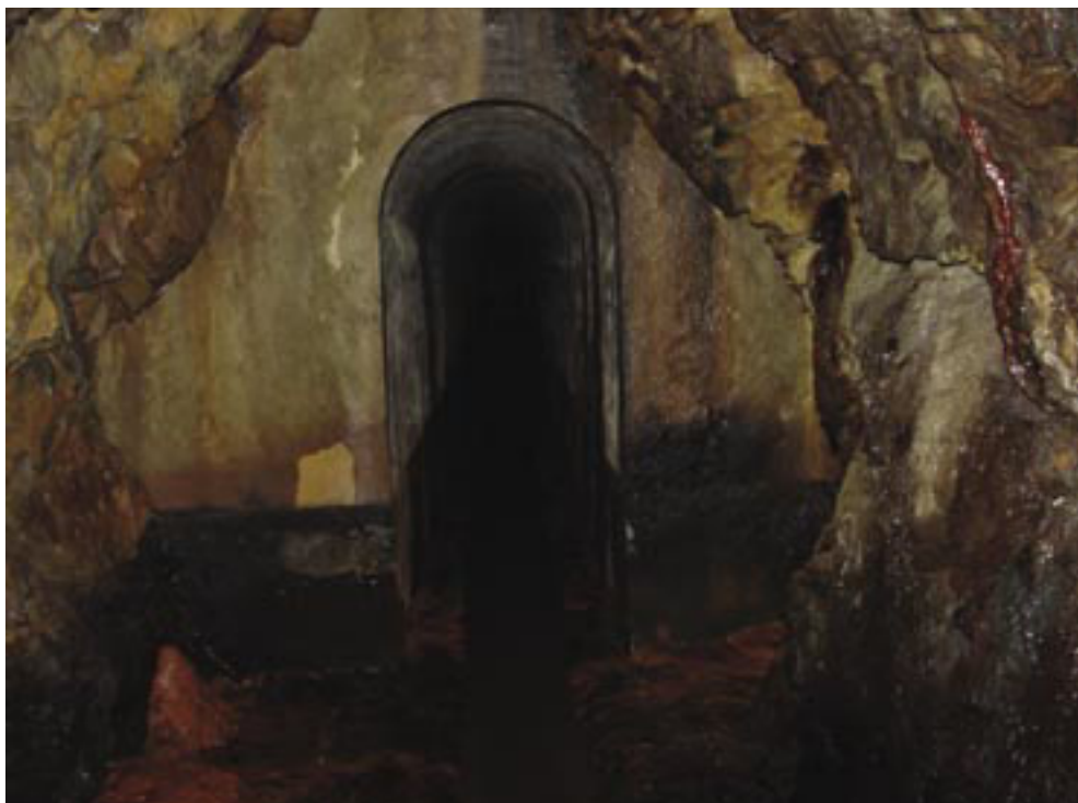
Photo 166 - Transition entre la galerie en pleine roche et le tunnel en b ton
