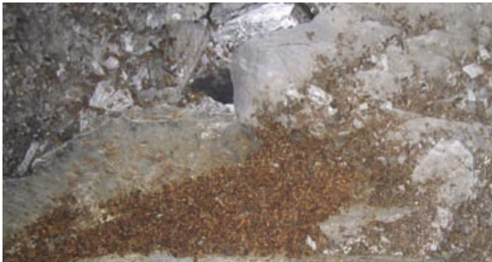
Photo 176 - Déjections de chauves-souris au sein de l'Ardoisière des Corbeaux
