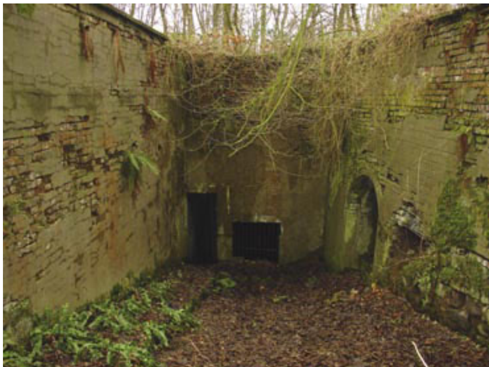
Photo 22 - Accès vers l'une des Galeries du Charbonnage de l'Espérance
