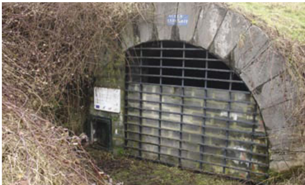
Photo 38 - Entrée sud du Canal de la Bête Refaite
