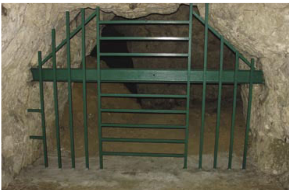
Photo 27 - Aménagement des accès au réseau souterrain
