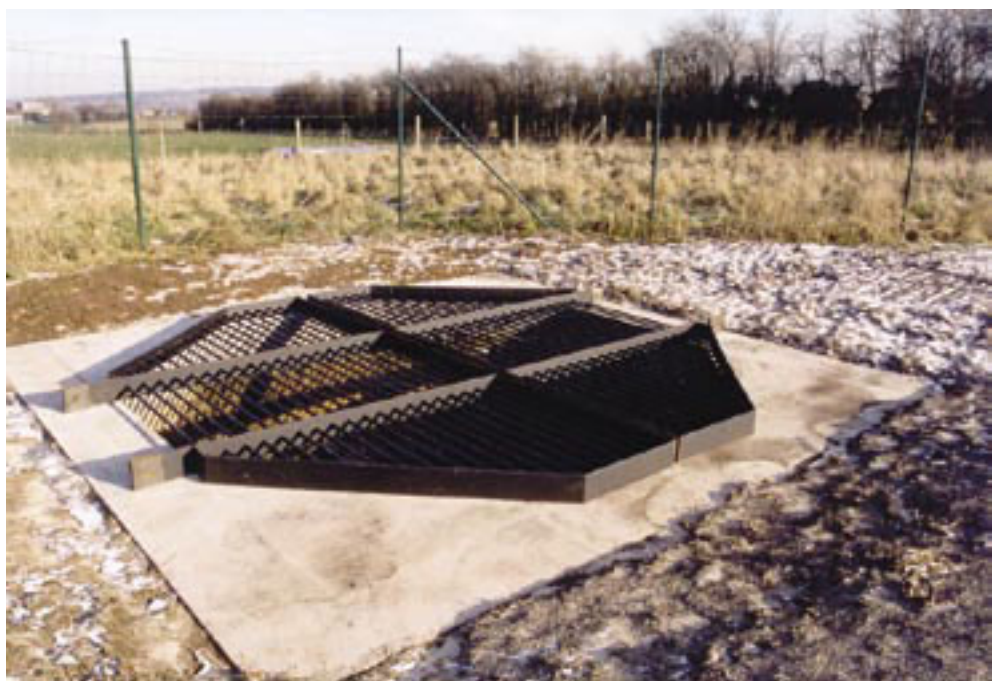
Photo 30 - Sécurisation des puits d'aérage
