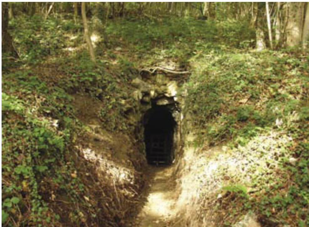
Photo 130 - Galerie d'acc s creus e dans les schistes
