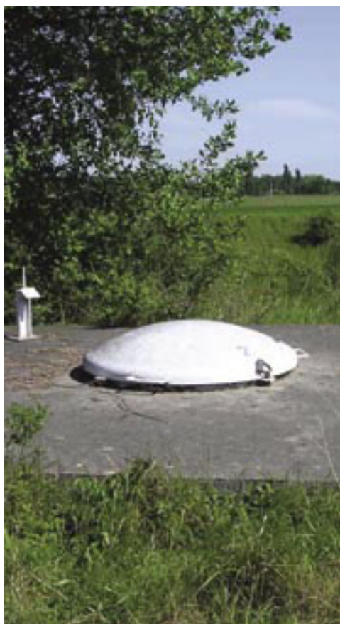
Photo 31 - Coupole fermant le puits avant aménagement
