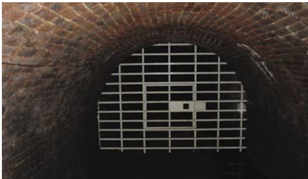
Photo 120 - Acc s au Tunnel de la Chartreuse
