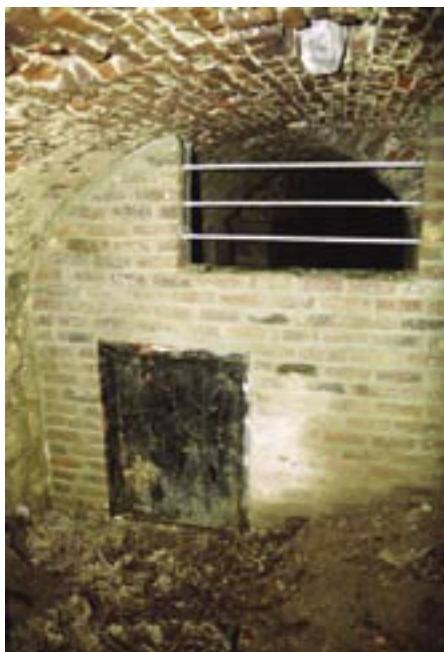
Photo 44 - Aménagement d'un des accès aux souterrains
