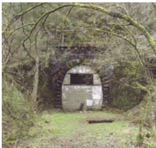
Photo 154 - Accès Nord du Tunnel de Maspelt
