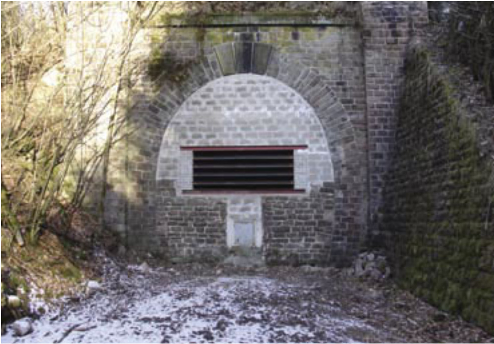
Photo 155 - Tunnel Est de Lommersweiler
