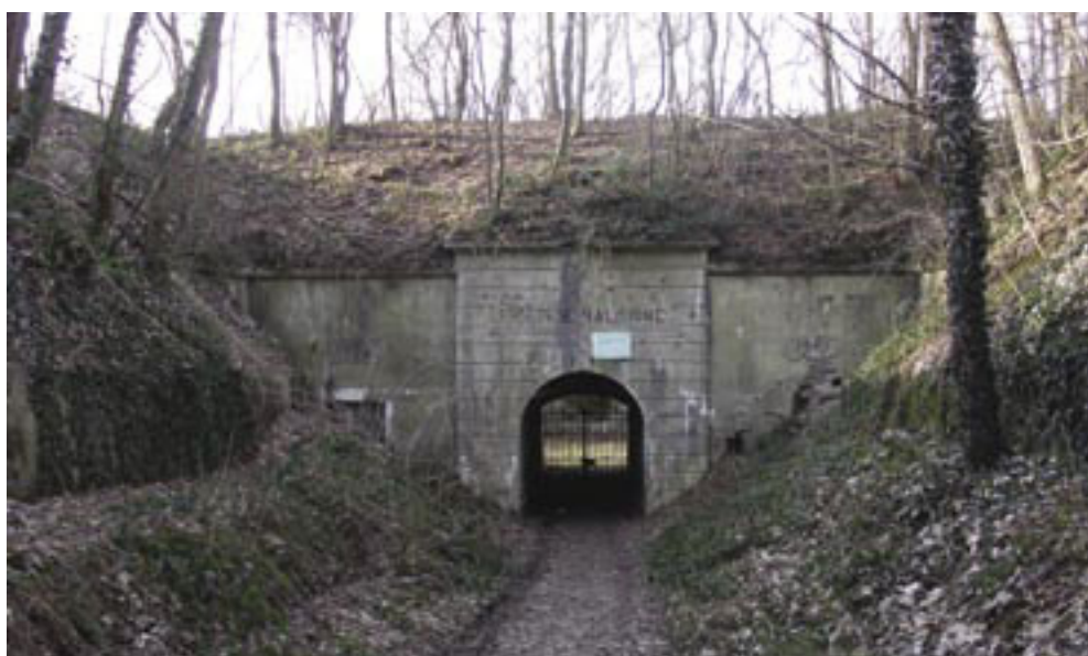
Photo 64 - Portail d'entrée du Fort de Malonne
