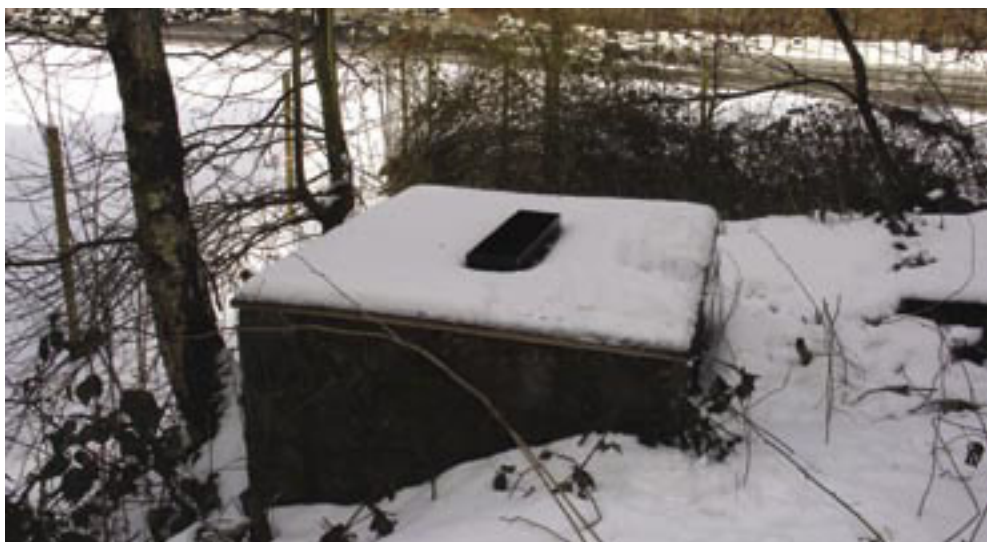
Photo 68 - Aménagement de puits d'aérage des souterrains
