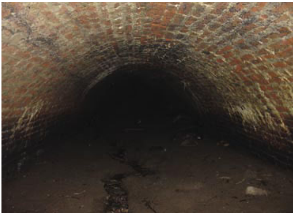
Photo 48 - Intérieur du tunnel
