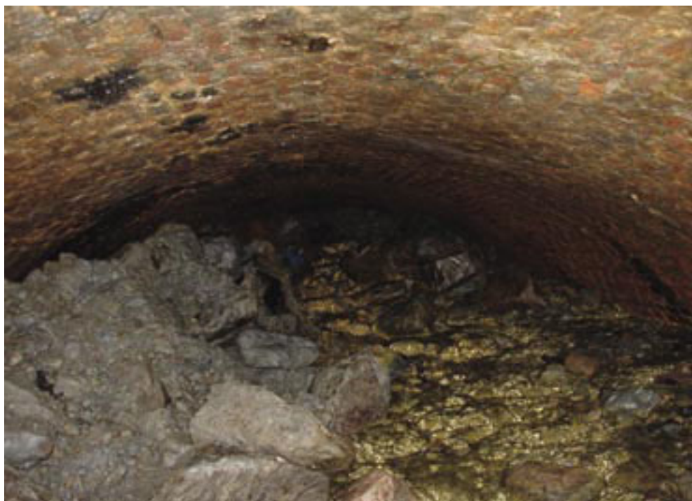
Photo 171 - Fin des travaux au fond du Canal
