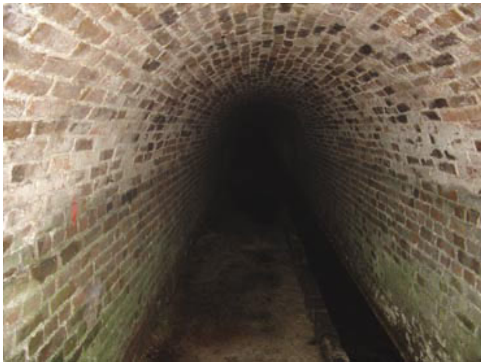
Photo 59 - Intérieur de la Galerie de Férauge
