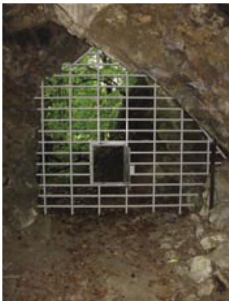
Photo 134 - Grille fermant la Galerie minière de Lovegnée
