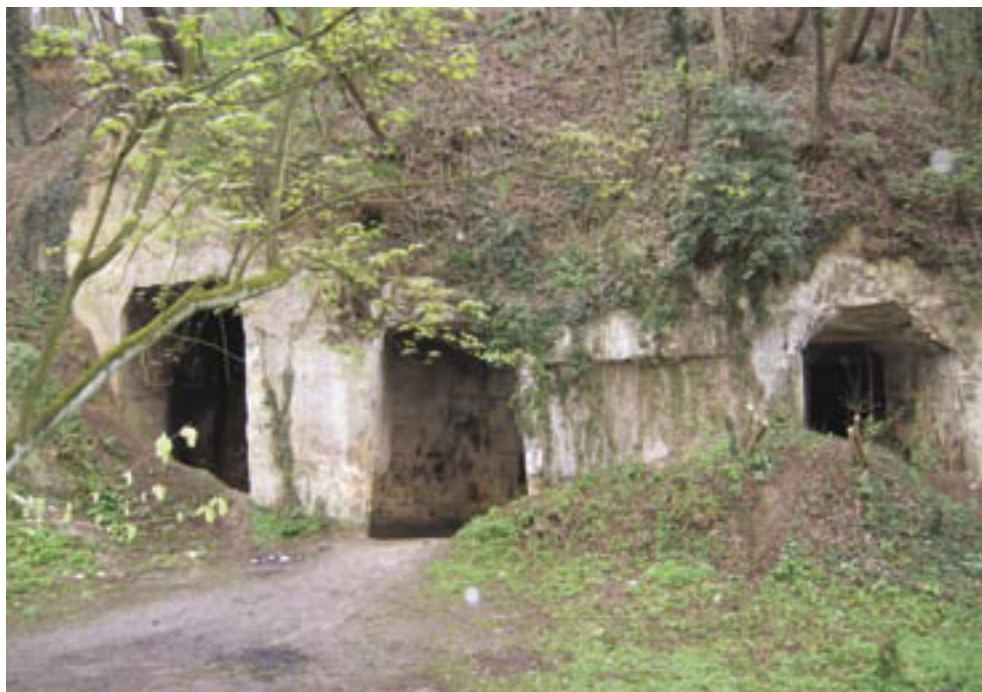
Photo 114 - Fenêtres d'entrée vers le réseau de Lanaye - inférieur
