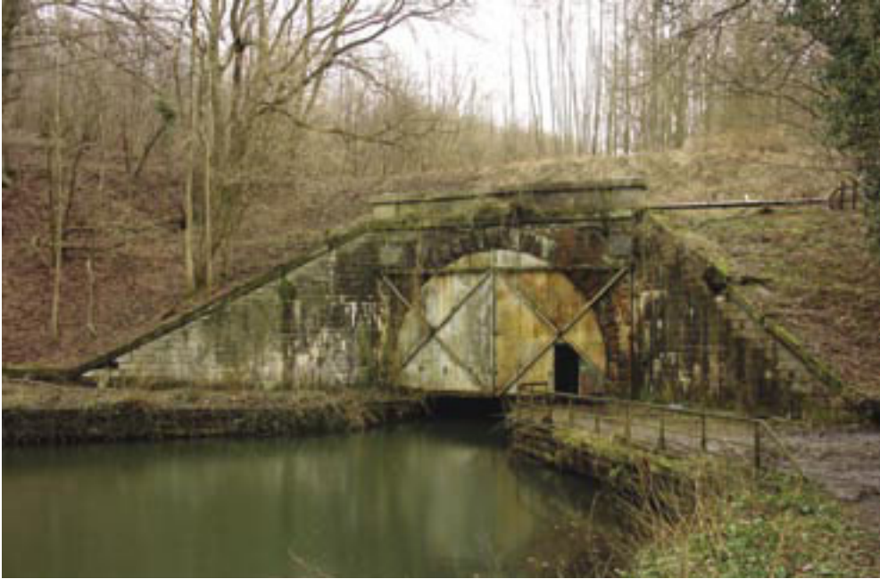
Photo 35 - Entrée sud du Tunnel de Plan Vert
