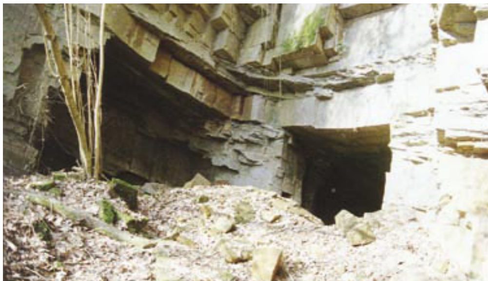
Photo 146 - Réseau amont des Carrières du Bellaire
