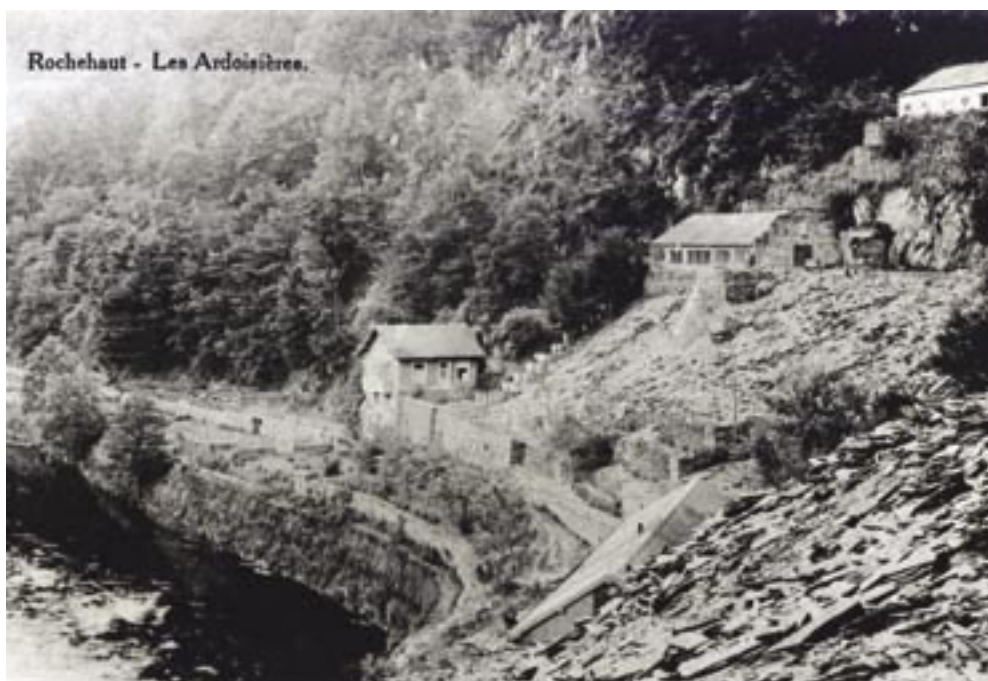
Photo 174 - Ardoisière des Corbeaux en exploitation
