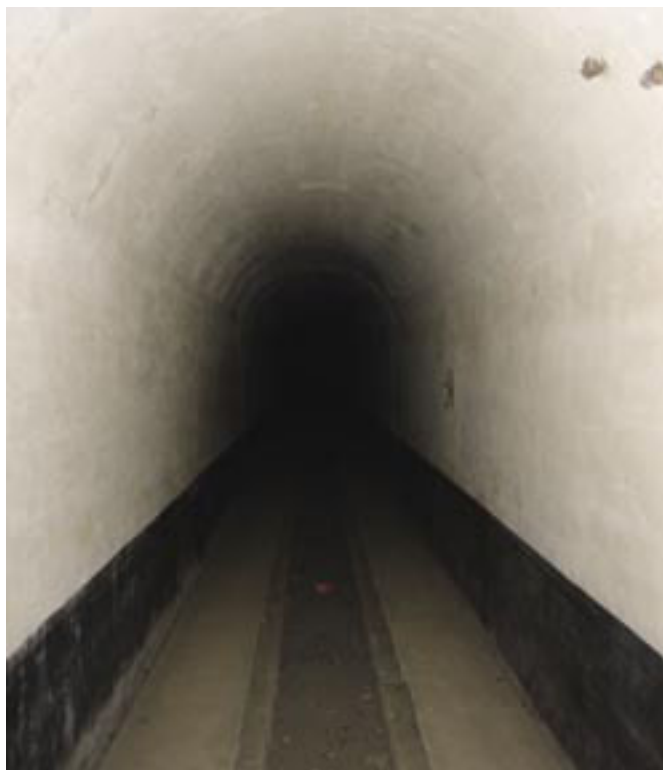
Photo 63 - Couloir au sein du Fort de Malonne
