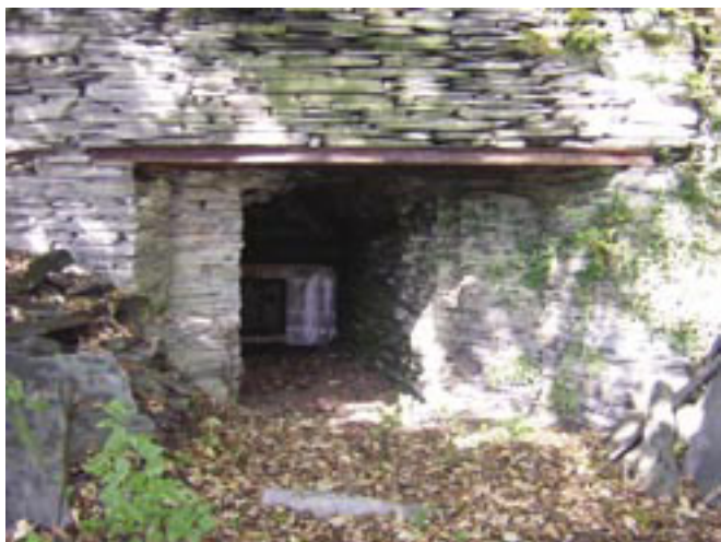
Photo 175 - Entrée vers le niveau supérieure de l'exploitation
