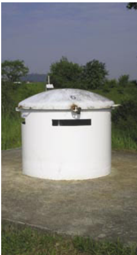
Photo 32 - Coupole fermant le puits après aménagement
