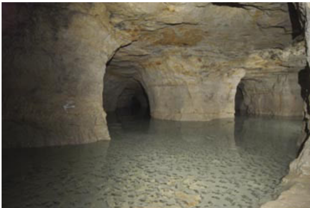
Photo 26 - Chambres d'exploitation avec piliers en diabolo et nappe affleurante
