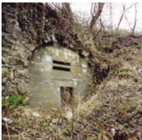
Photo 47 - Ancien four à chaux de la RND de Jamioulx
