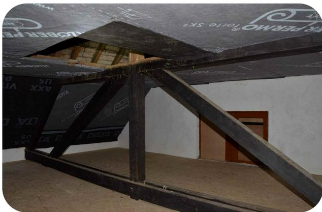
**Le comble tamponné avec accès à la hot-box au-dessus. Dans le fond, une ouverture pré-existante a été transformée en chiroptière avec chicane.**
