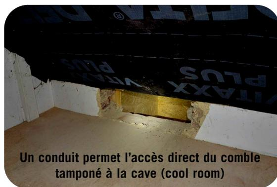
**Un conduit permet l'accès direct du comble tamponné à la cave (cool room)**
