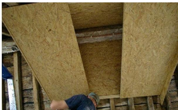
Notre aménagement est presque terminé, il reste à boucher les ouvertures du toit (avec des plaques en bois) et des murs (avec une maçonnerie en brique) et créer une chiroptière en chicane. Pour les boiseries en contact avec l'extérieur, pensez à utiliser du panneau marin afin qu'il n'absorbe pas l'humidité et que les prédateurs ne puissent pas s'agripper et rentrer à l'intérieur.
