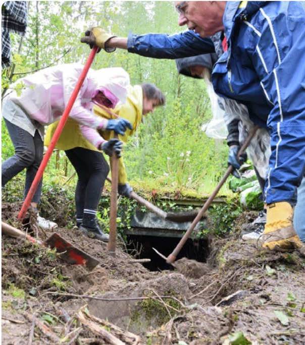
Chantier d'aménagement de l'ancien local de pompage
