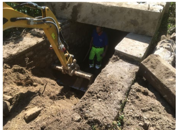
Chantier d'aménagement de l'ancien local de pompage
