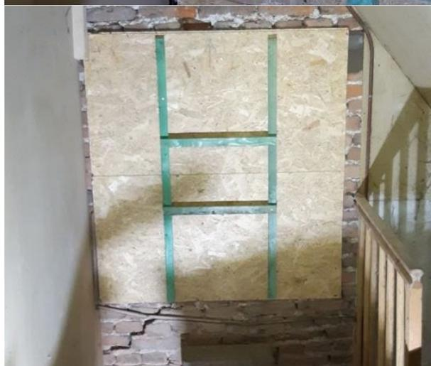
L'accès pour les hommes - L'ouverture d'accès à l'aménagement est fermée à l'aide d'une plaque retenue à l'aide de renfort intérieur ainsi que par une cale extérieure (morceau de bois fixé dans le coin supérieur gauche). Une fois la plaque enlevée, il est possible d'accéder à l'aménagement par l'ouverture dans le mur.
